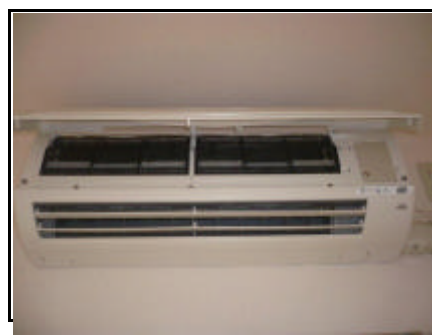
エアコン 内部洗浄済み
