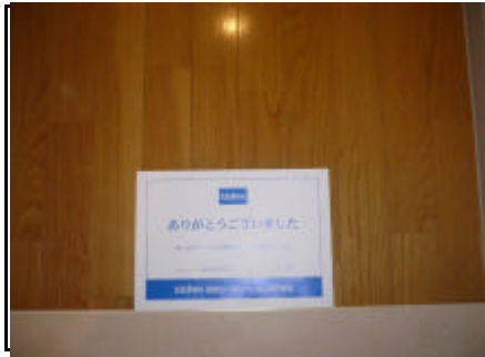
玄関土間 完了シート設置済み
